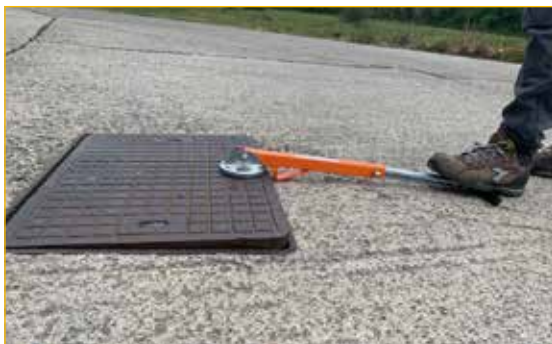
Sblocco chiusino tramite perno centrale
